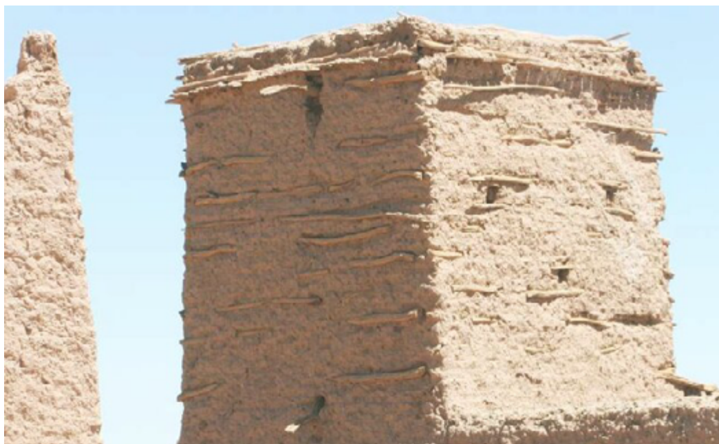
Εικ.11 Κτίριο rammed earth που επηρεάστηκε από καιρικές συνθήκες, στο M'hamid El Ghizlane, νότιο Μαρόκο, Errachidia Association
