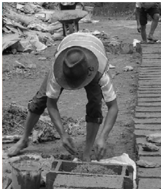
Εικ.40 Κατασκευή ομόπλινθων στην Urubamba Valley, Cusco, Peru 1
