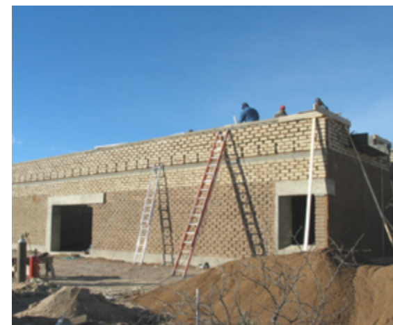
Εικ.131 Ωμόπλινθοδομή κατά την κατασκευή, Box Box, Ραέλ σαν Φρατέλο, Μαρφά, Τέξας
