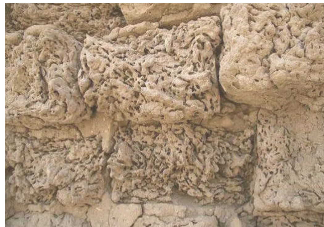
Εικ.12 Φθορά από τερμίτες σε ωμοπλινθοδομή, Langenbach, 2005
