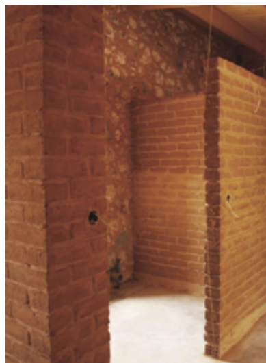
Εικ.96 Φέροντας οργανισμός, Σεμιναριακός Χώρος, Southern Architects, Δράπανο Αποκορώνου Εικ.97 Λεπτομέρεια εσωτερικής ωμοπλινθοδομής, Σεμιναριακός Χώρος, Southern Architects, Δράπανο Αποκορώνου
