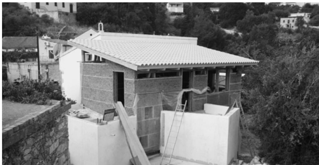
Εικ.79 Κατοικία στο Βαφέ, με ξύλινο σκελετό και τοιχοποιία από μείγμα αχυροπηλού. Μέρος της κατοικίας είναι επίσης από φέρουσα οπτοπληθδομή
